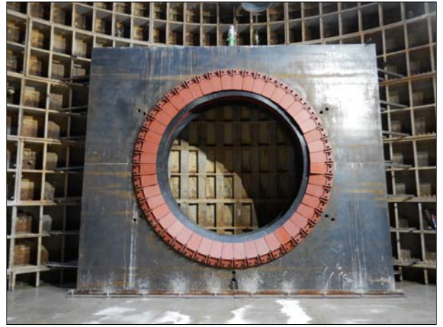
写真-2 エントランス設置状況
