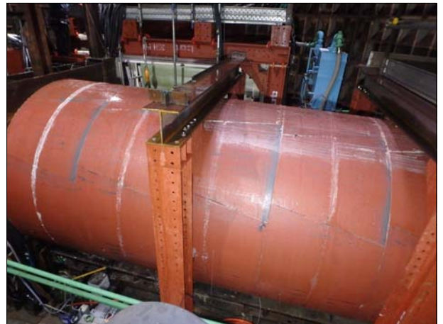
写真-3 浮き上がり防止鋼材設置状況
