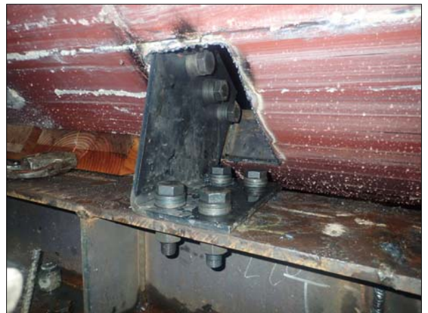
写真-4 発進架台とのボルト締結状況
