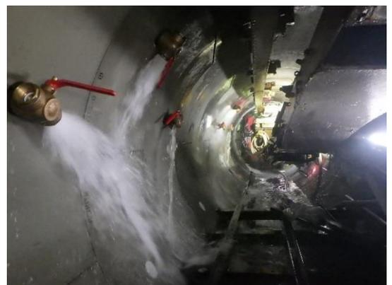
写真-1 切羽水抜き状況
