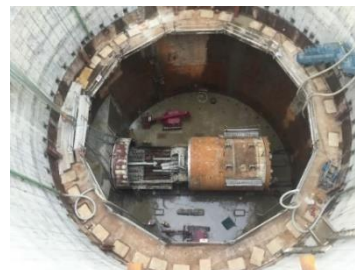
写真-4 排水完了後状況
