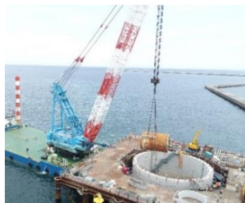
写真-5 マシン引き上げ
