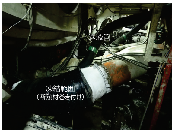
写真-2 液体窒素による排泥管の凍結
