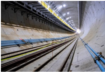
写真-2 坑内状況
