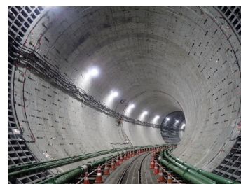
写真-4 切削セグメント組立状況
