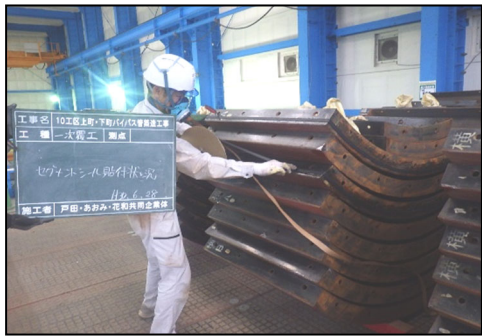
写真-2 セグメントシール貼り状況
