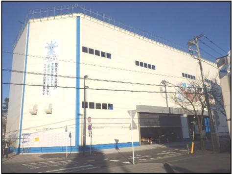
写真-1 防音ハウス全景
