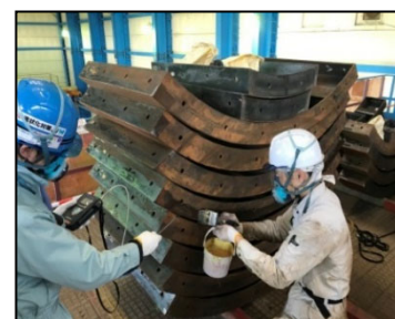
写真-3 蒸気濃度測定状況
