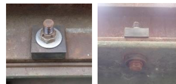
図5 レール締結装置外観
