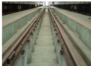
図1 車両検修線全景
