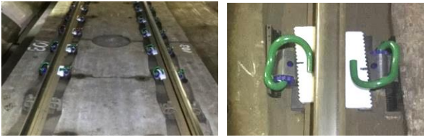
図 5 施工後の状態
