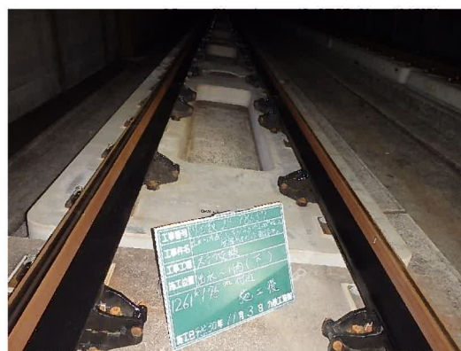
写真-2 施工後現場
