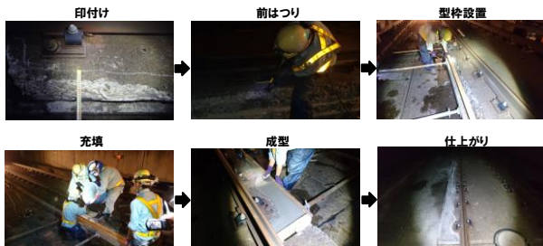
図-3 本体成型工程概略
