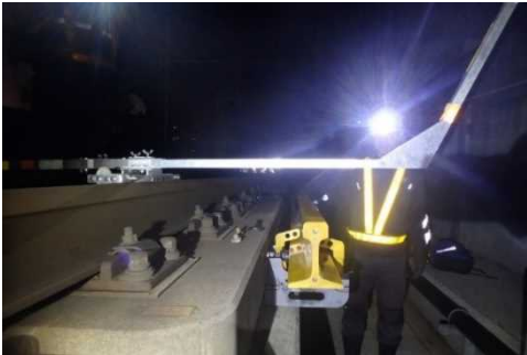
写真 3 レール取卸後の建築限界測定
