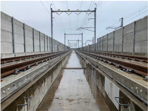
写真 1 貯雪型スラブ軌道
