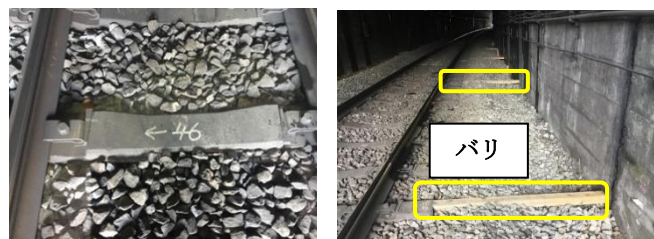
図6 施工概要(左：移動量記載，右：バリの設置)
