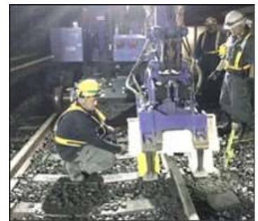
写真2 施工境界部用加振治具
