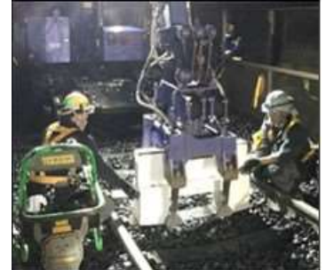
写真3 施工中央部用加振治具
