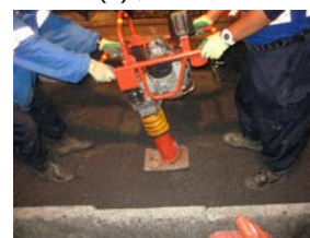
(c)ランマーによる転圧
