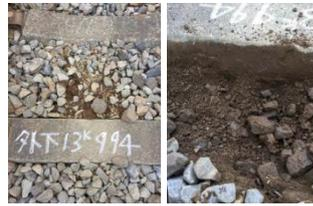
図2 道床状態(土砂混入)
