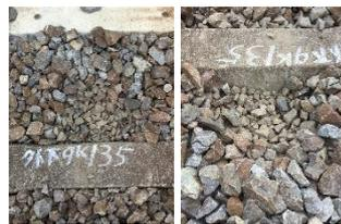
図4 道床状態(細粒化)
