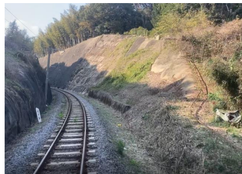
写真-2 長崎旧線：東園～大草(113k000 付近)
