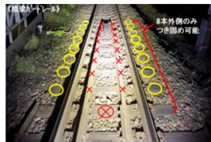
図-7 橋上ガードレール端部
