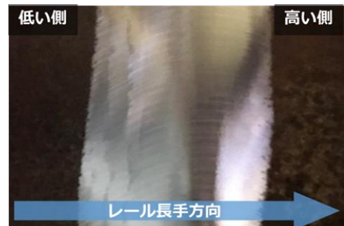
写真-2 仕上げ状態
