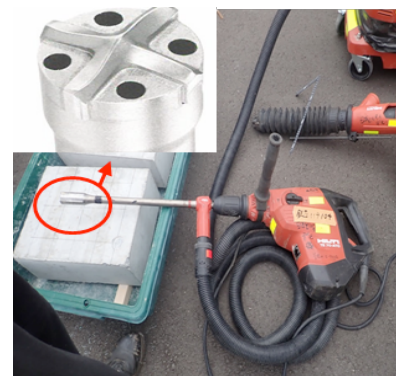
図-2 穿孔機と集塵機
