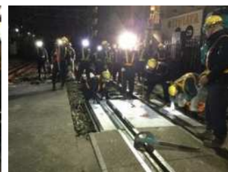
写真2 簡易連軌設置
