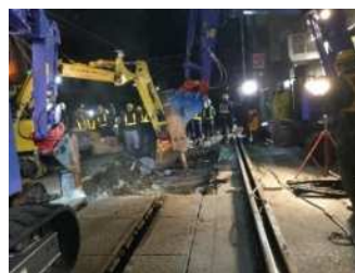
写真1 路盤掘削（支障物撤去）
