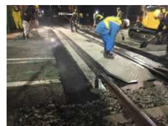
写真4 60k 接続軌道敷設
