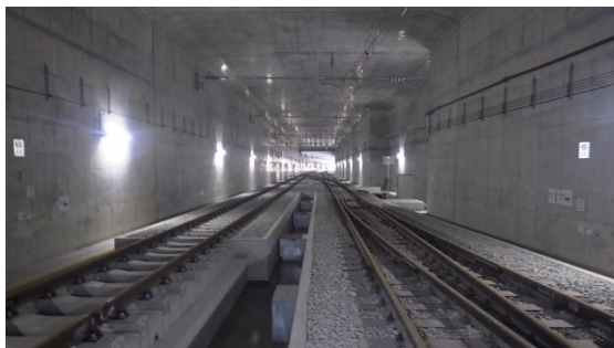
写真-1 折尾トンネル内
