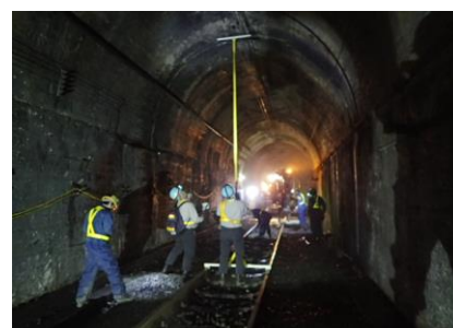
図Ⅳ. 架線高さ検測作業状況
