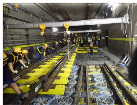
写真-2 移動式分岐器吊上げ装置
