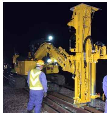
写真-5 作業全景
