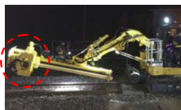
写真-9 改良前 移動時
