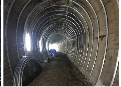
写真-5 T形支保工設置完了
