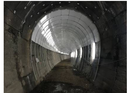
写真-6 内面補強工完了
