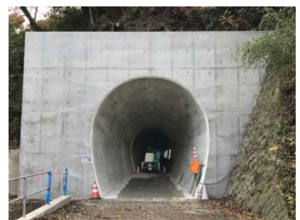
写真-9 坑口完了
