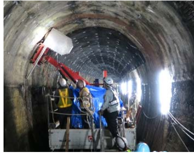
写真-4 Tカッター
