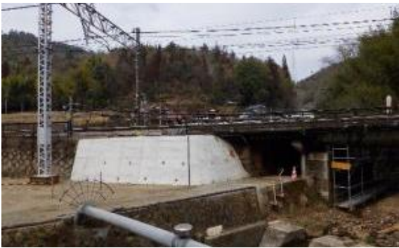
写真-2 工事完成
