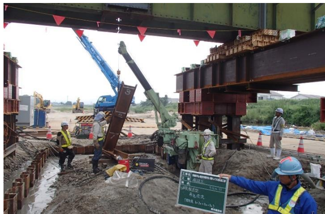
図-7 土留め工 鋼矢板圧入状況
