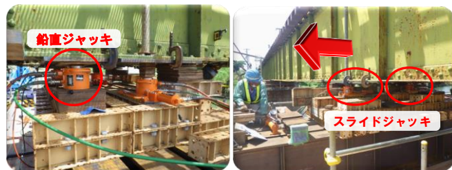
図-4 鋼桁の位置整正状況
