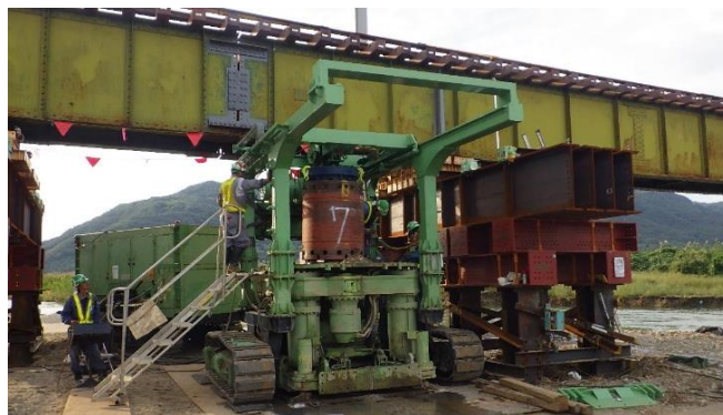
図-8 場所打ち杭工 掘削回転圧入状況
