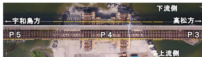
図-5 仮受け完了
