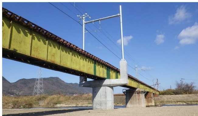
図-9 本復旧完了
