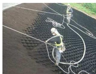
図-10 植生基材吹付け状況
