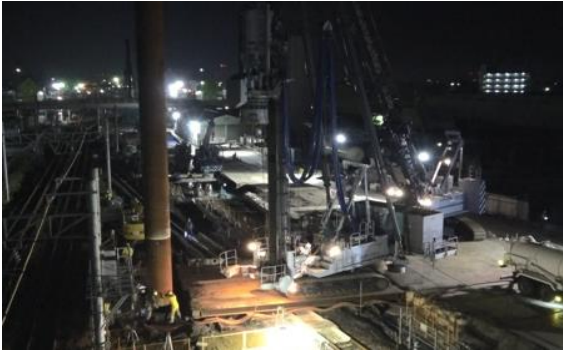
写真-1 鋼管ソイルセメント杭施工状況
