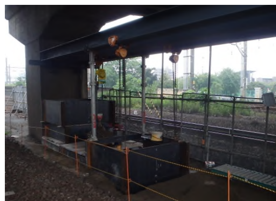
写真-1 エレメント沈設状況
