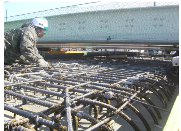
写真-3 NV コンクリート打設状況
