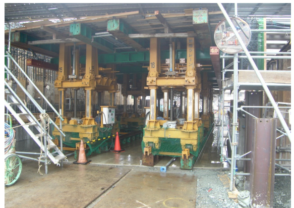
写真-1 リフター支保状況
