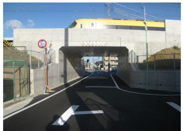
写真-4 新設躯体外観
