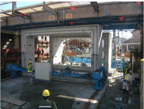
写真-2 PCa-Box 据付状況
