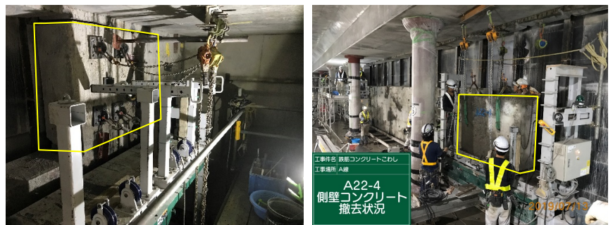
写真-1 特殊台車を用いたコンクリート塊撤去状況
