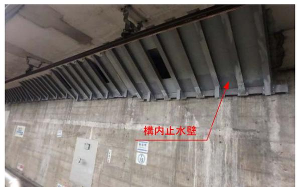
写真1 構内止水壁設置状況
