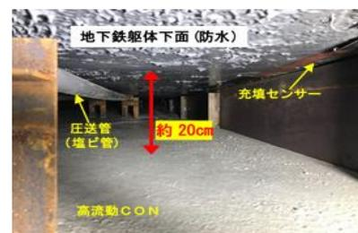
写真-3 モルタル充填箇所状況
