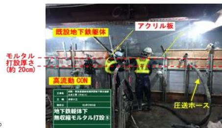
写真-4 棲部での施工・充填確認
