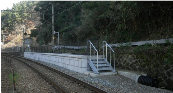
図-5 上りホーム完成写真
