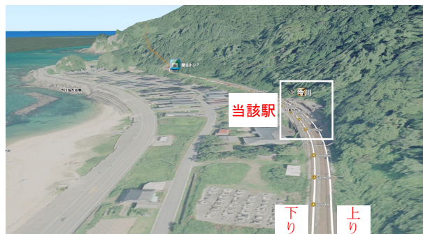
図-1 駅ホーム全景
