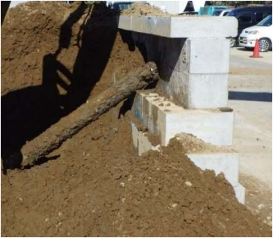
写真-1 掘り出し状況 (θ = 30°)
