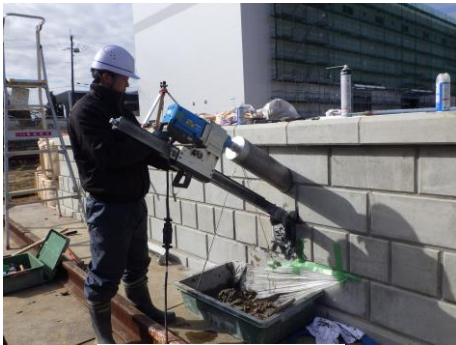
写真-1 削孔状況
