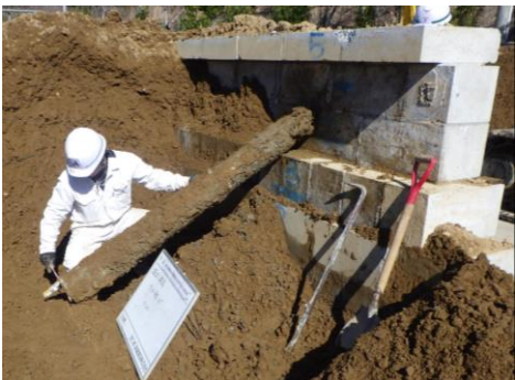
写真-2 形状確認・アンカー角度 30^\circ
