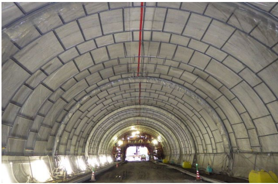
写真－2 覆工コンクリートの給水養生状況
