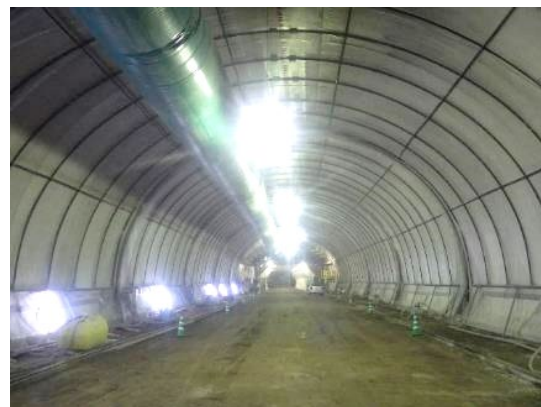
写真-1 シート吸引方式給水養生工法全景
