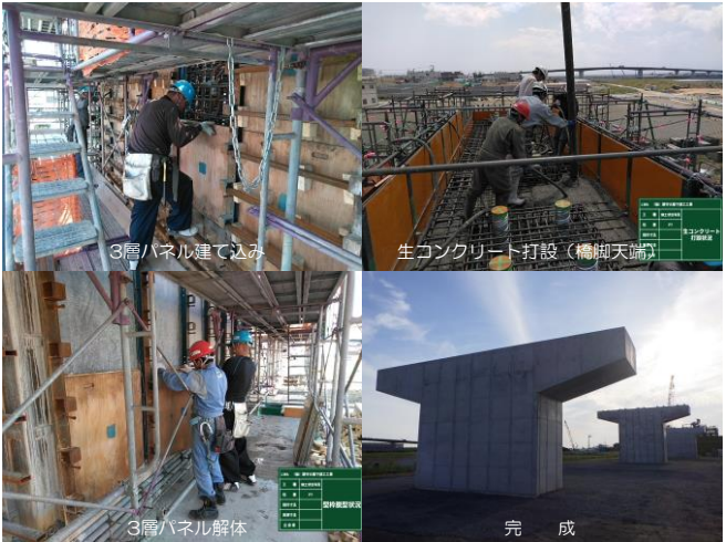
写真- 1 「CF 工法」施工状況
