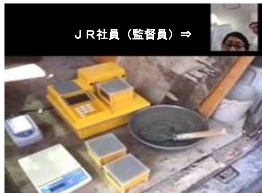
図-3 ビデオ通話での施工確認状況
