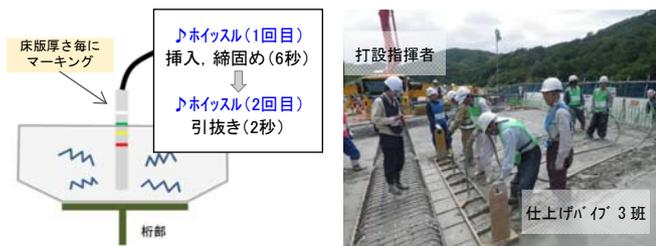
図-3 締固め時間
