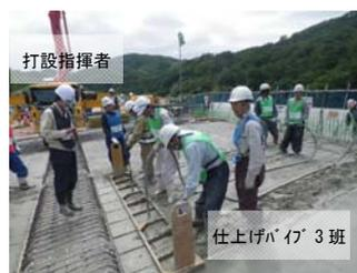
写真-3 締固め状況
