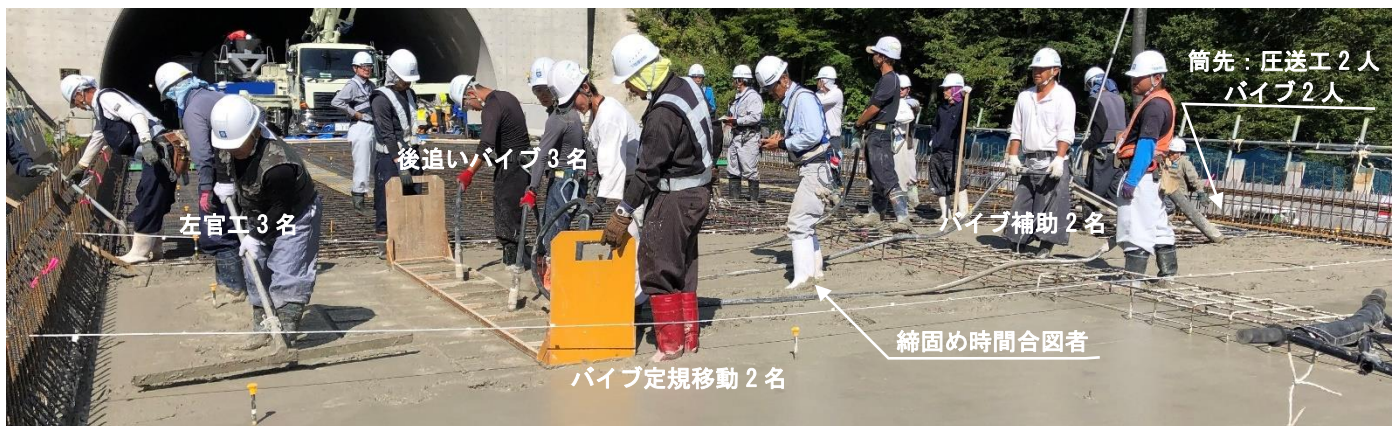
写真-1 コンクリート打込み状況
