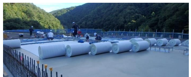
写真-4 養生シート敷設状況
