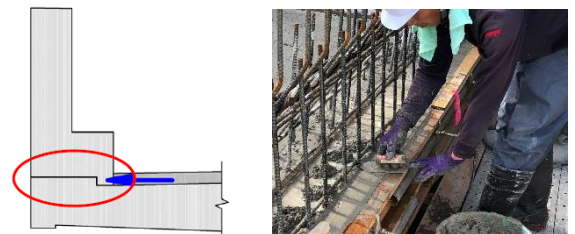
写真-3 地覆部の段差管理
