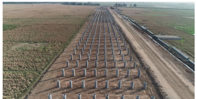
図-6 打設完了状況
