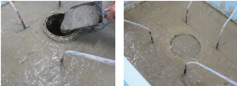
(a) ソイルセメント投入状況 (b) 投入完了 写真-1 模擬改良体の作製状況
