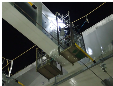
写真－1 ボルト締結部塗装作業
