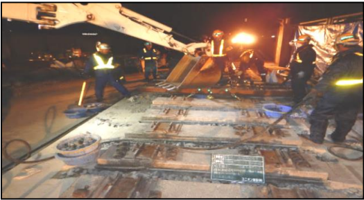
写真-1 軌陸 BH による弾性直結マクラギ撤去
