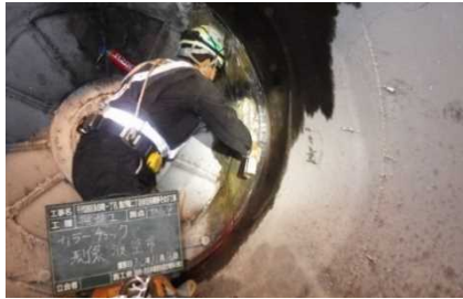
写真 3 溶接チェック状況
